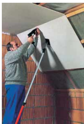
Befestigung von Gipskartonplatten
