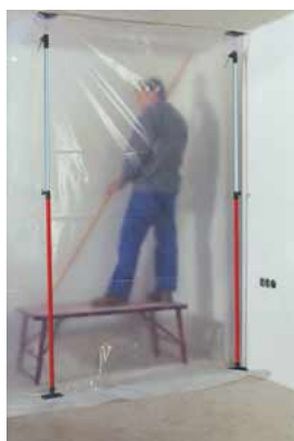
Erstellung einer Staubschutzwand
