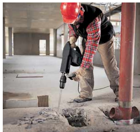
Ideal für Abbrucharbeiten und Durchbrüche.
